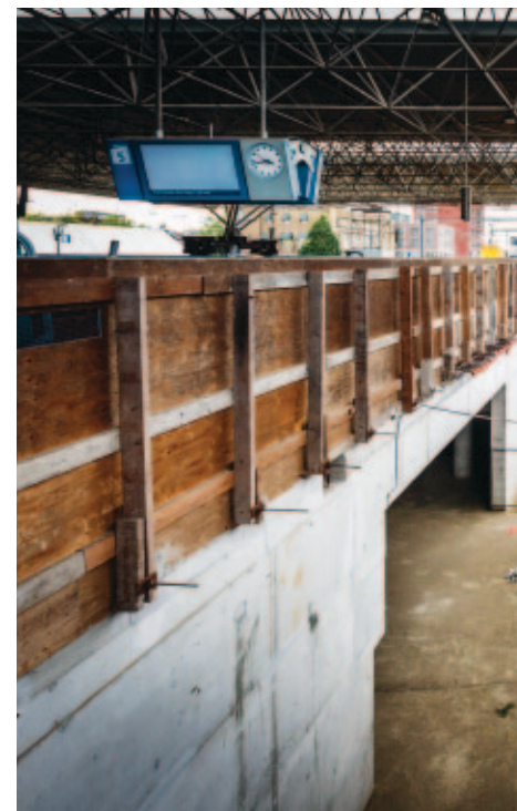
Nieuwe reizigerstunnel in aanbouw.
