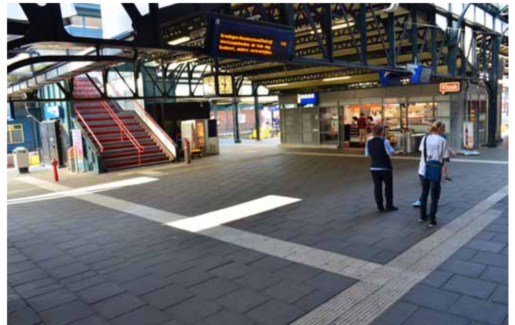
- Traverse komt uit op huidige perronplein -
