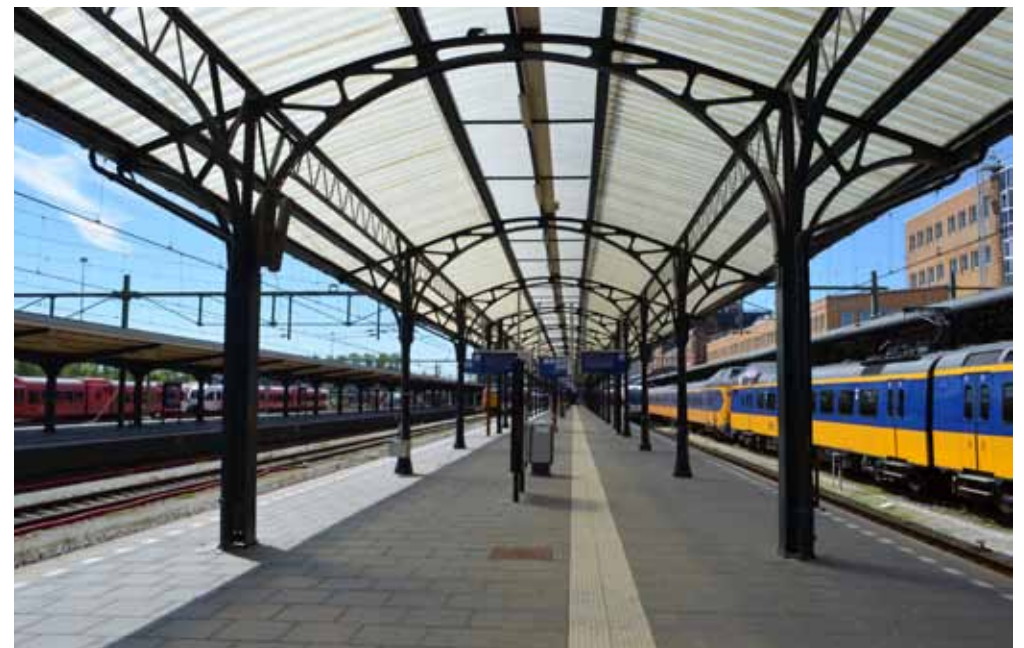
- Dak perronkappen reeds aangepast i.v.m. lichtere ruimte -
