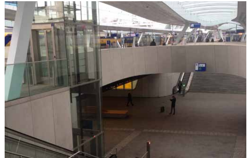
- Perrontunnel Station Arnhem Centraal - perronkap is ook dak tunnel - grote openingen -
