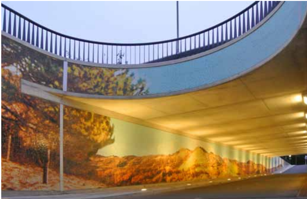
- Fietstunnel Wassenaar - kunstwerk tegen lange dichte wand -
