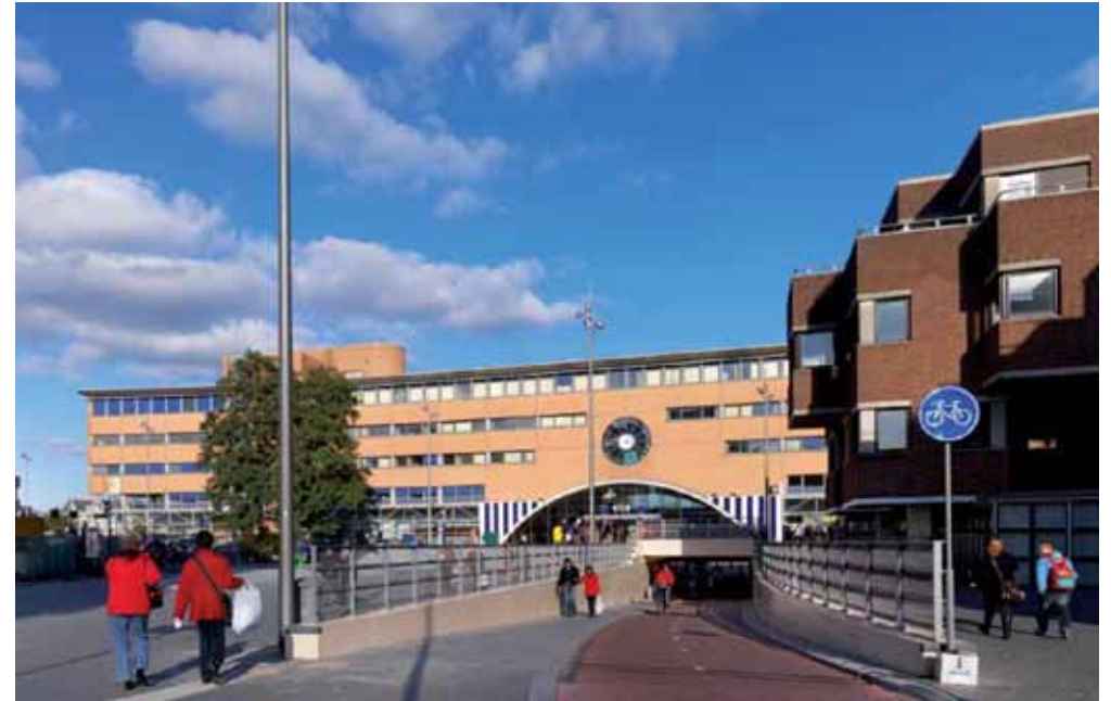
- Station Hilversum - entree perrontunnel en fietstunnel gescheiden -
