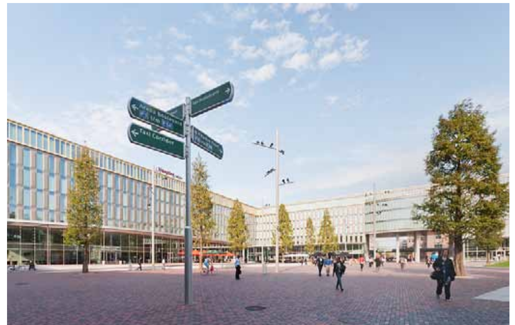
-Hoekenrodeplein bij Station Amsterdam Bijlmer Arena - gebouw als poort naar perrontunnel -
