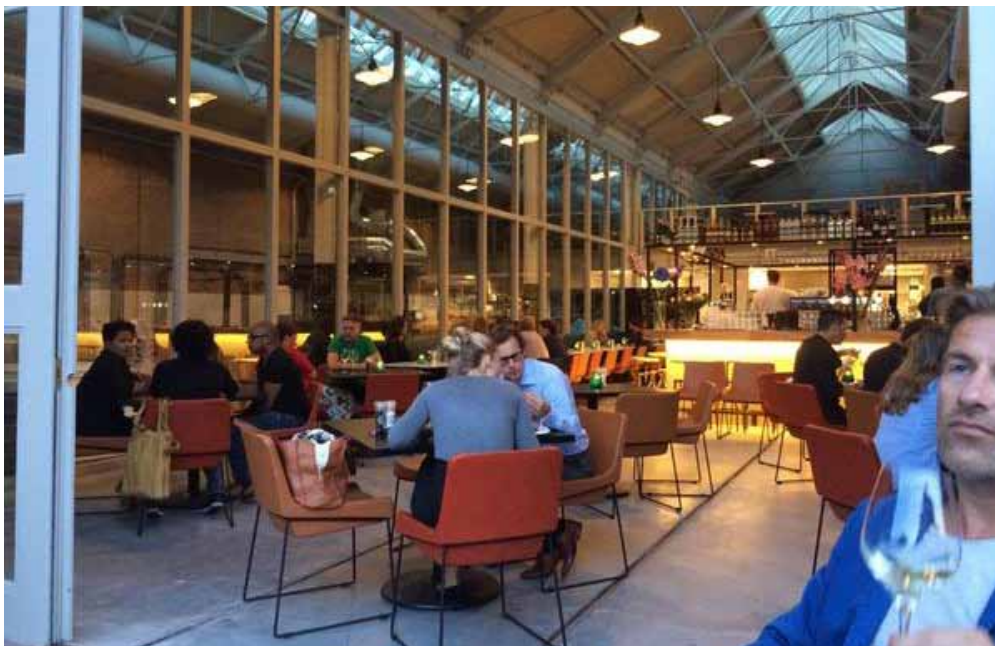
- Markthallen Amsterdam - nieuwe functie - bestaand dak met nieuwe glazen wanden -
