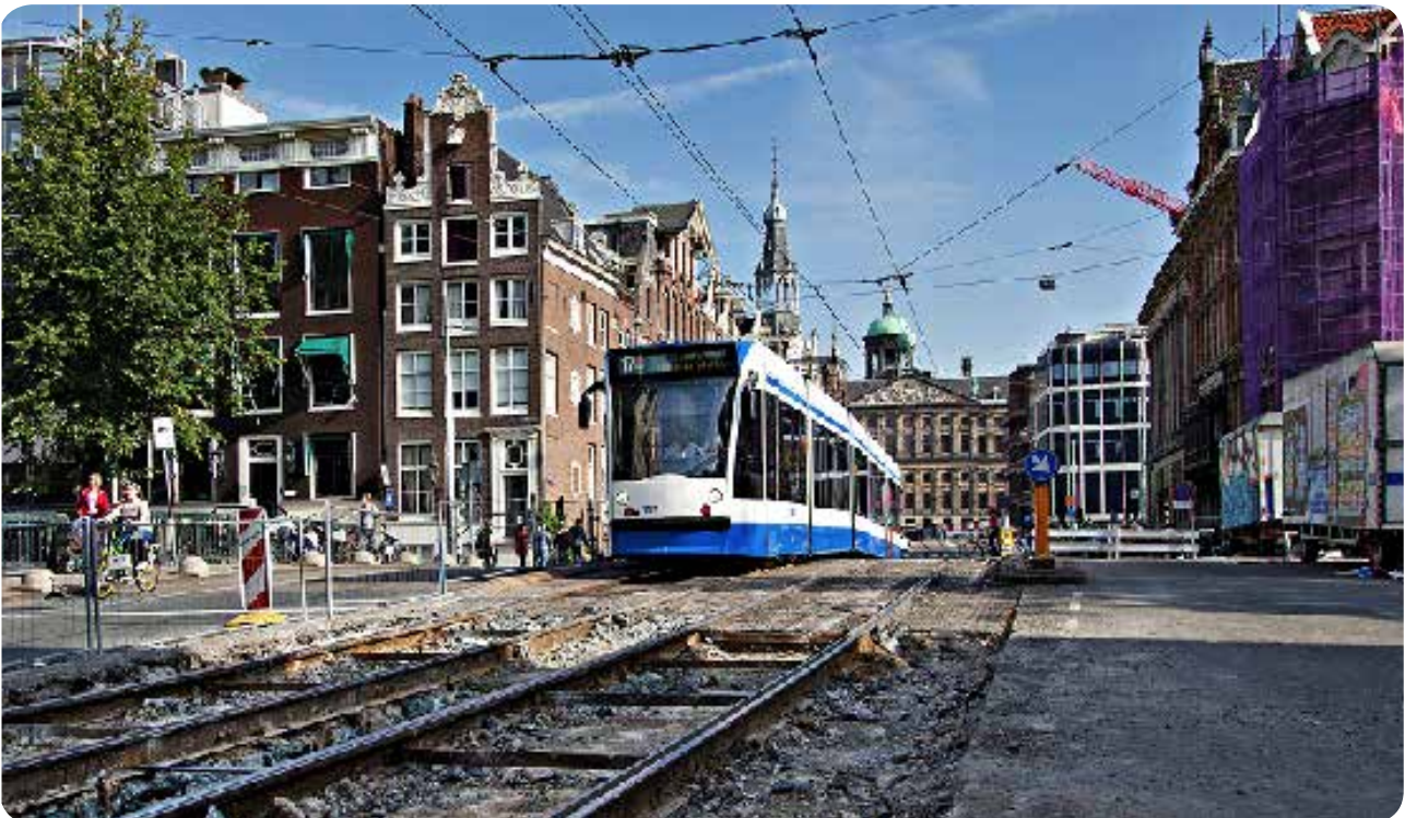
Werkzaamheden aan de trambaan in de Raadhuisstraat, voor het paleis op de Dam.
