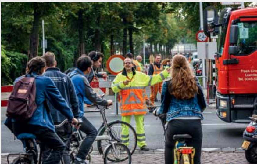
Omleiding wegens werkzaamheden. Prins Hendriklaan.
