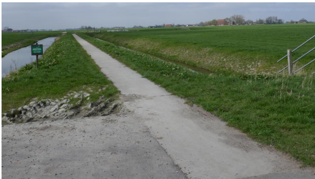
Afbeelding 18 – Nieuw aangebracht fietspad bij het Tjerkepad. Bron: Bindert Kloosterman 2017
