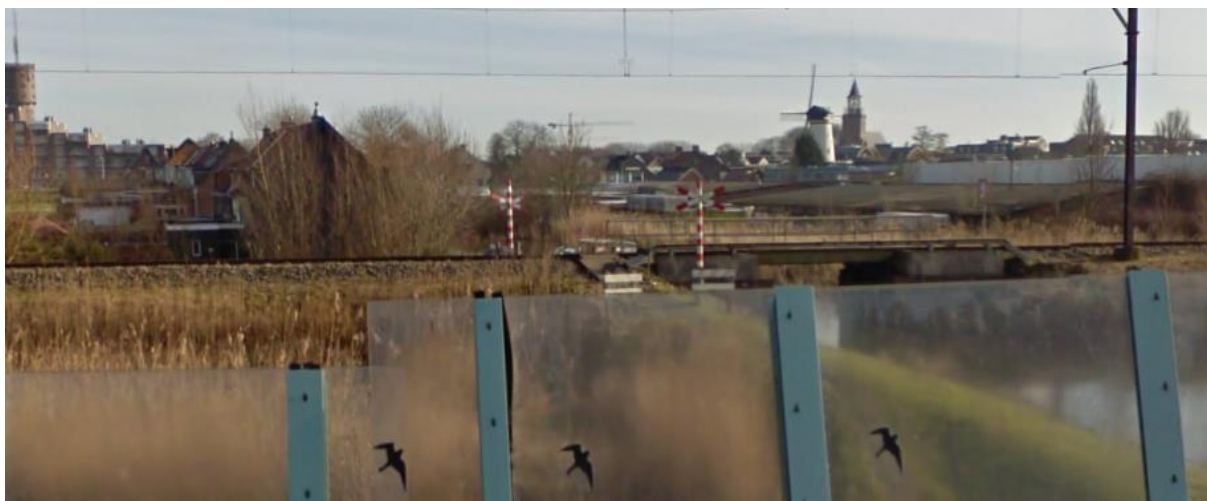
Afbeelding 359 – Overweg Bodegraven. Bron: Kees Rotteveel 2017
