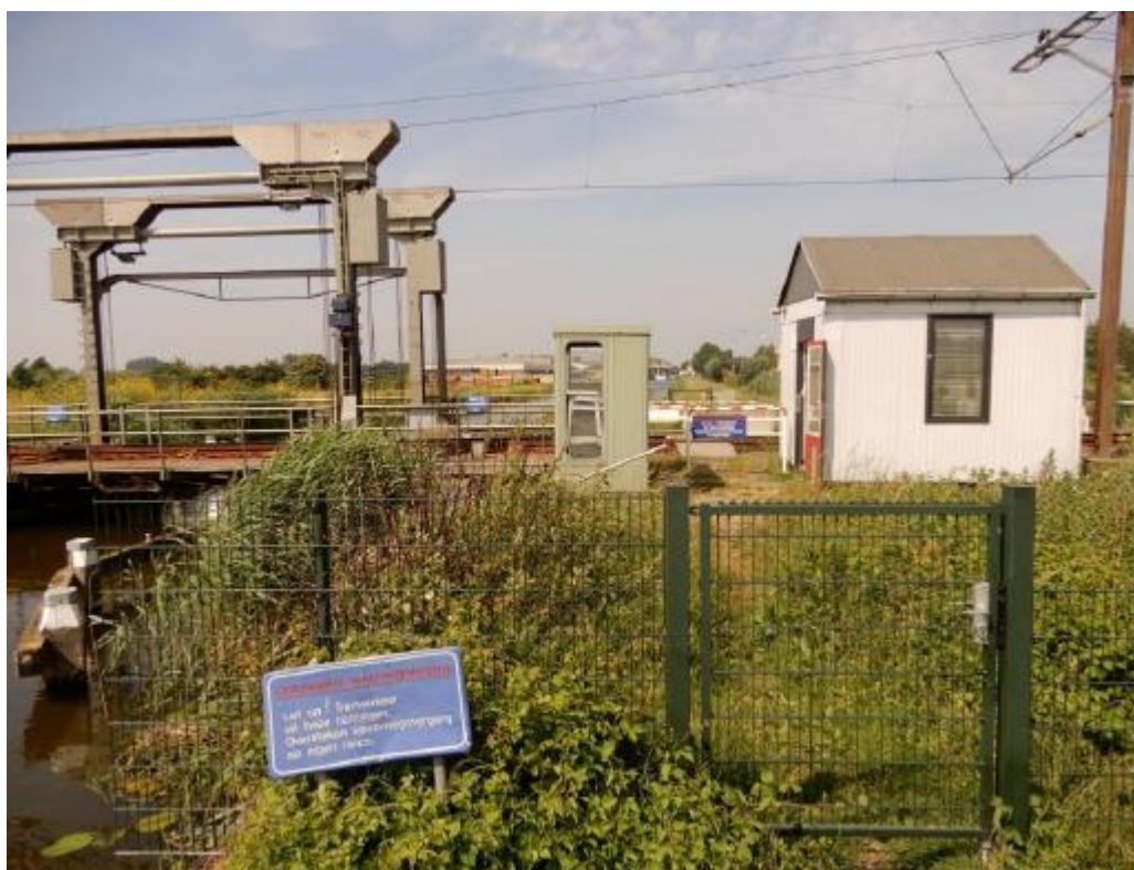
Afbeelding 353 – Overweg Bodegraven. Bron: Kees Rotteveel 2017
