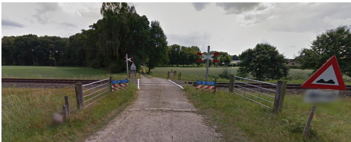
Afbeelding 166 – Hulzerdijk. Bron: Google StreetView 2017
